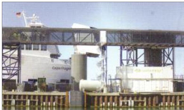
Das Wasserbehandlungssystem MarinePaq wurde im Hafen von Gedser installiert.
