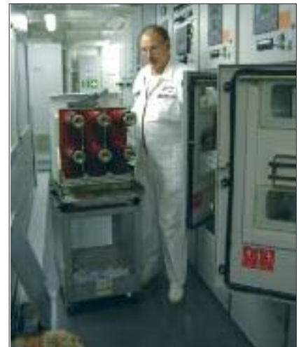
Arbeiten an der Mittelspannungsschalttafel
