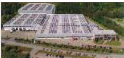
Luftbildaufnahme des Kabinenwerks in Wismar. Foto: MV Werften
