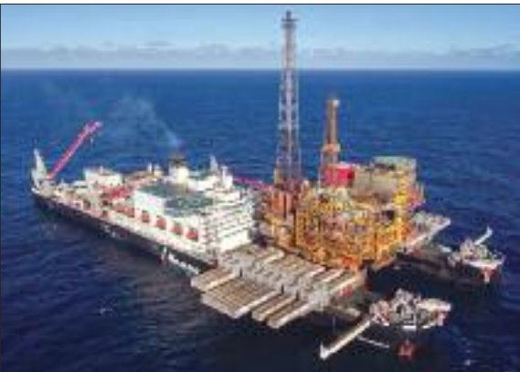
Abbildung 14: Die 1976 errichtete und im April 2017 abgebaute Produktionsplattform Brent Delta wird zur Abwrackwerft transportiert. Quelle: Allseas
