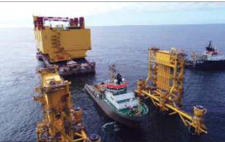
Abbildung 10: Die HGÜ-Plattform Dolwin gamma wird von Schleppern in die Absetzposition bugsiert. Quelle: Tennet
