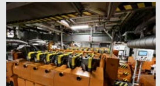
Blick in den Maschinenraum mit 4 Bergen Engines Gas-Otto-Motoren. Foto: husare gmbh
